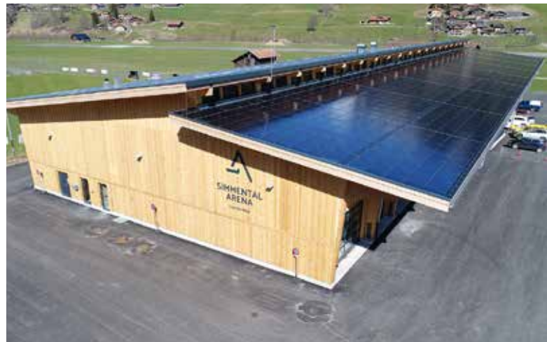
Zwei Dächer, welche die SolarUp Energie GmbH realisiert hat
